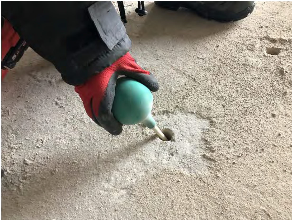
Рис. 4.2.4. Чистка шпура от пыли
