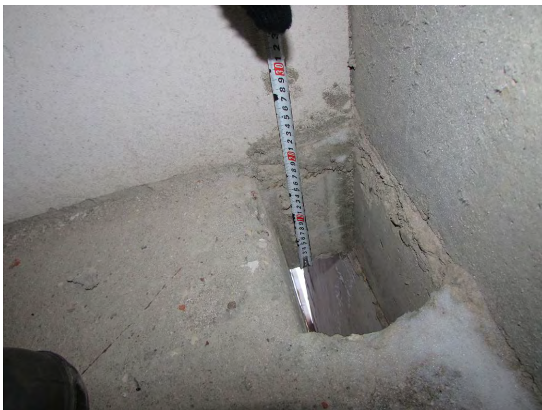
Рис. 3.3.2. Замер толщины монолитной ж.б. плиты перекрытия
