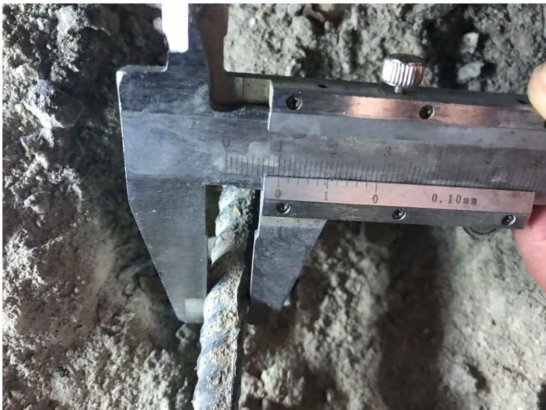
Рис. 3.3.4. Замер диаметра армирования рабочей арматуры плиты перекрытия 2-го этажа верхнее армирование
