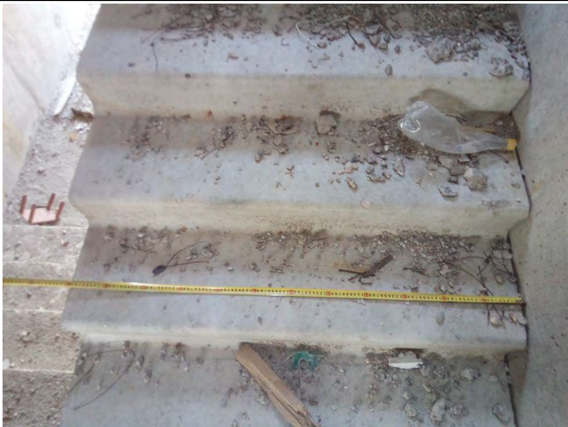
Рис. 3.5.2. Замер ширины лестницы 6-ой секции в осях «Л-Р/31-32»
