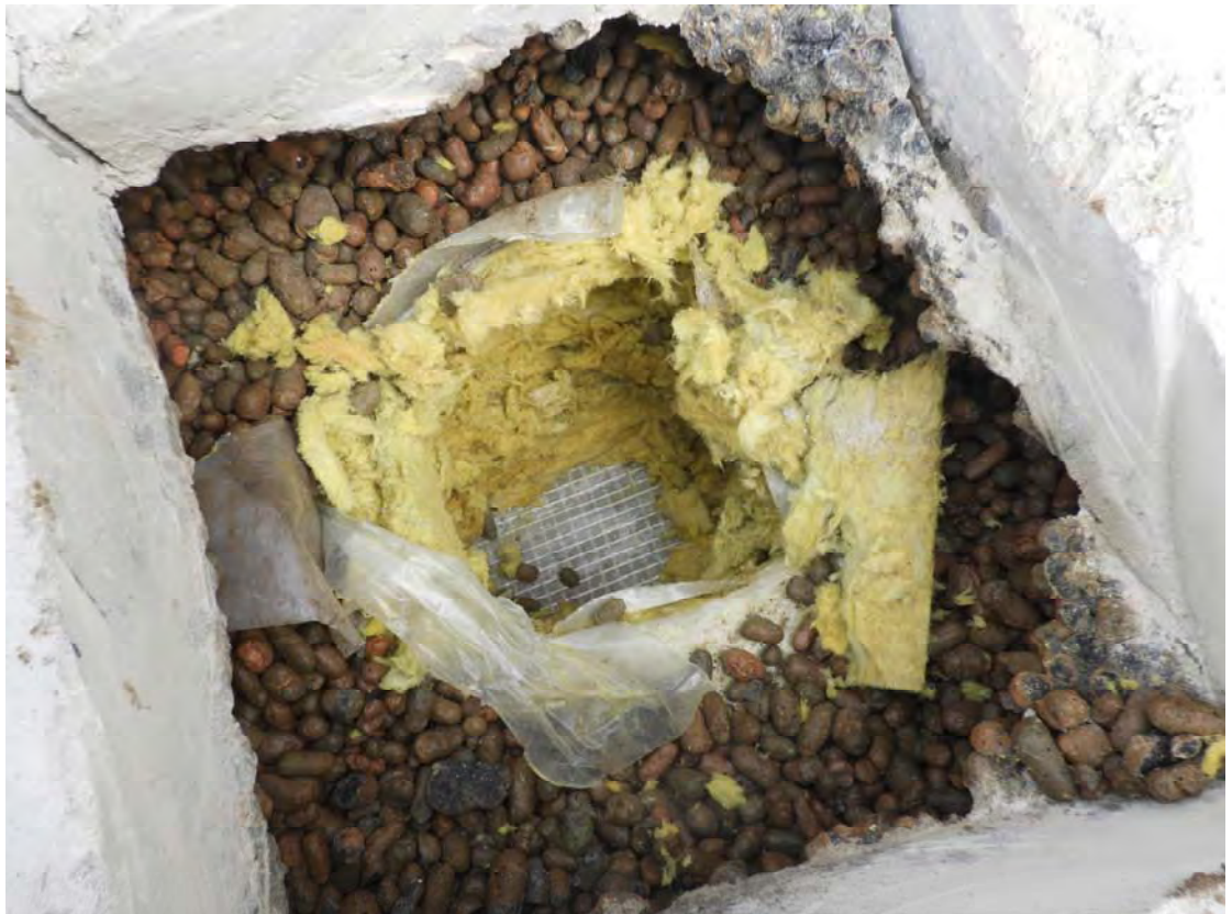
Рис. 3.6.2. Общий вид участка вскрытия кровли секции 1 в осях «10-11÷ММ-НН»
