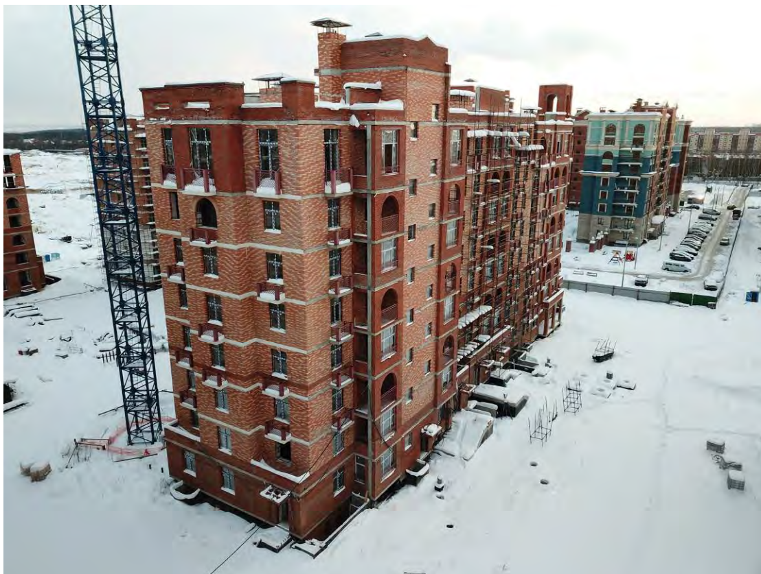
Рис. 1.1. Фасад жилого дома №5 корпус 1 в осях А-ММ
