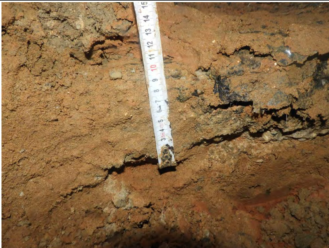
Рис. 3.1.5. Уточнение толщины бетонной подготовки (100 мм)
