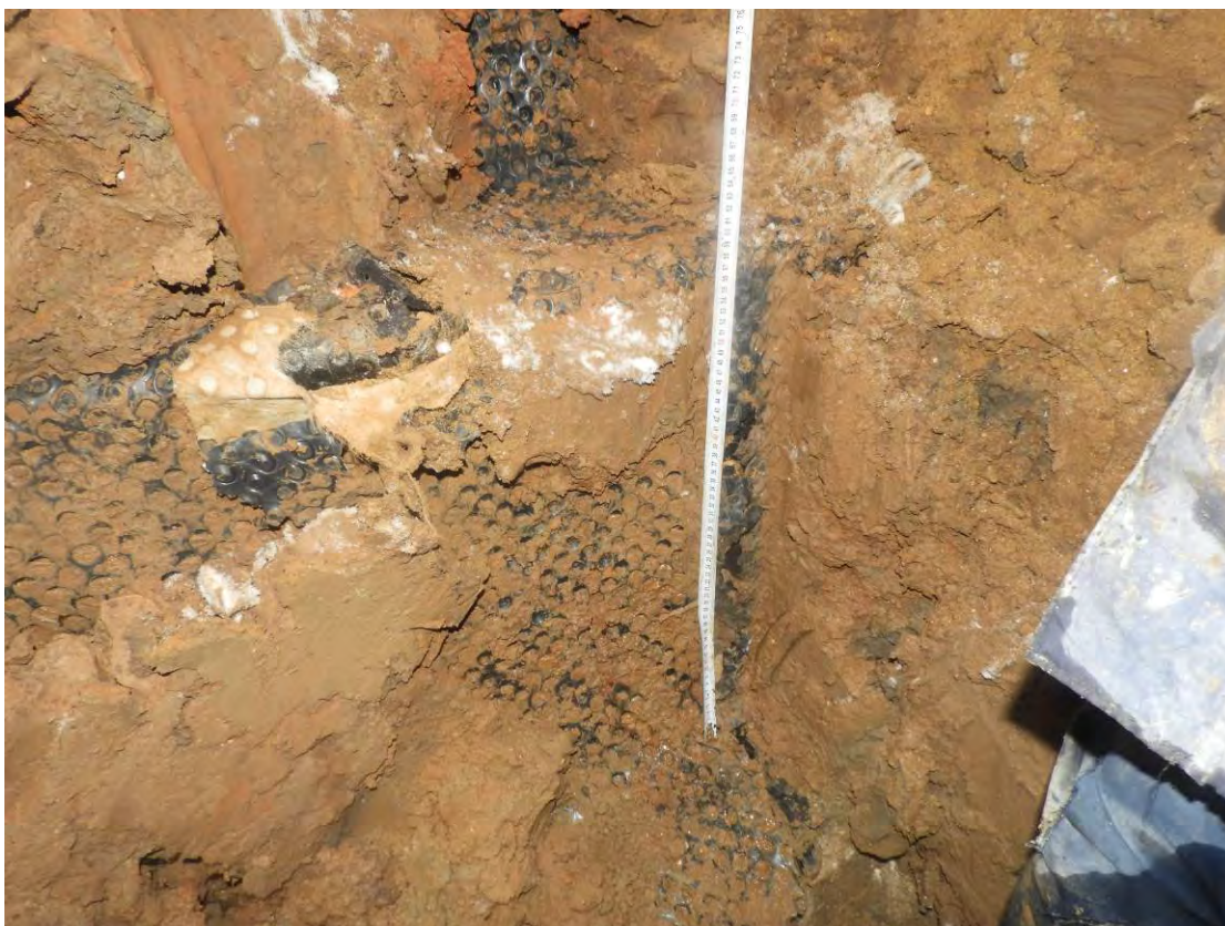
Рис. 3.1.4. Уточнение толщины фундаментной плиты (600 мм)
