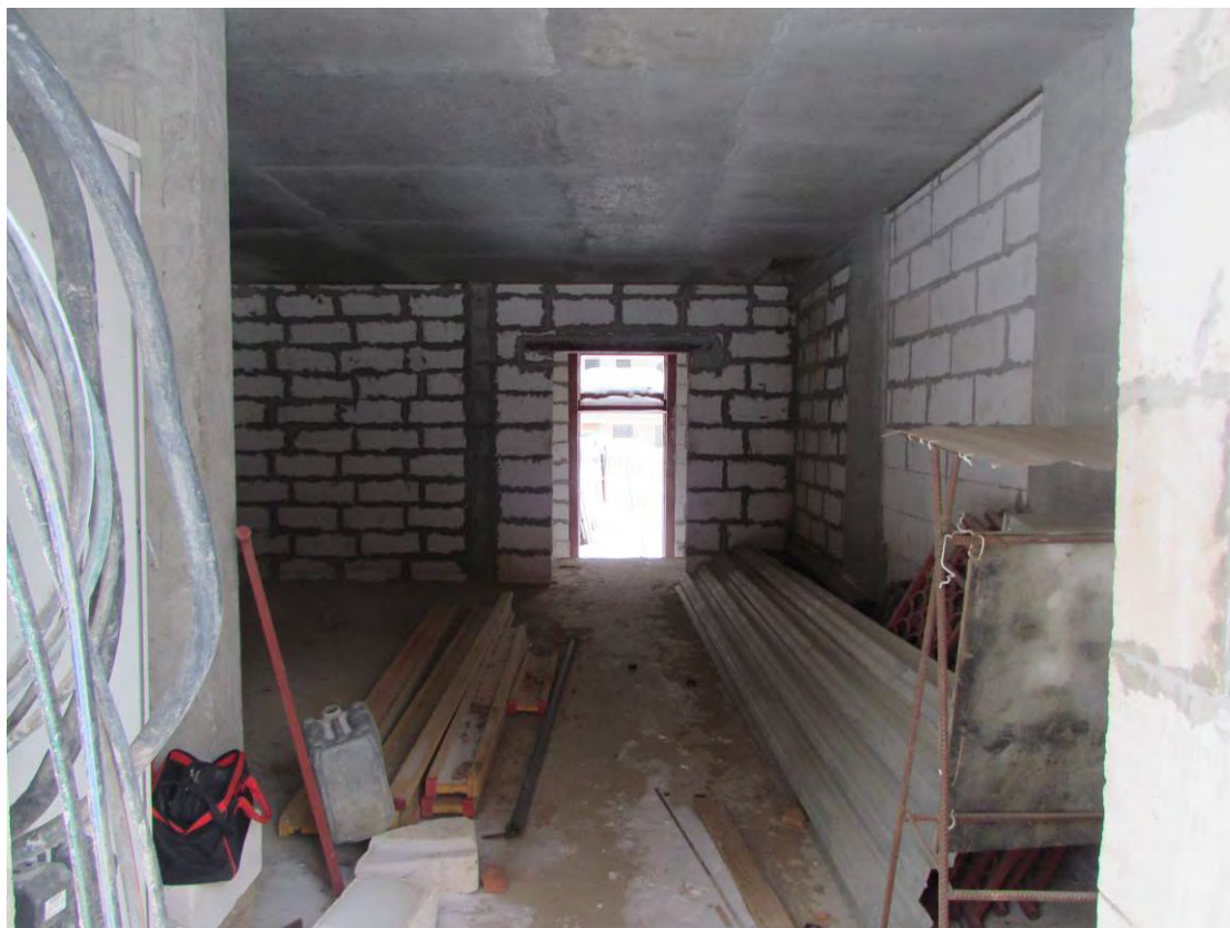
Рис. 3.2.1. Общий вид вертикальных конструкций 1-го этажа секции 1
