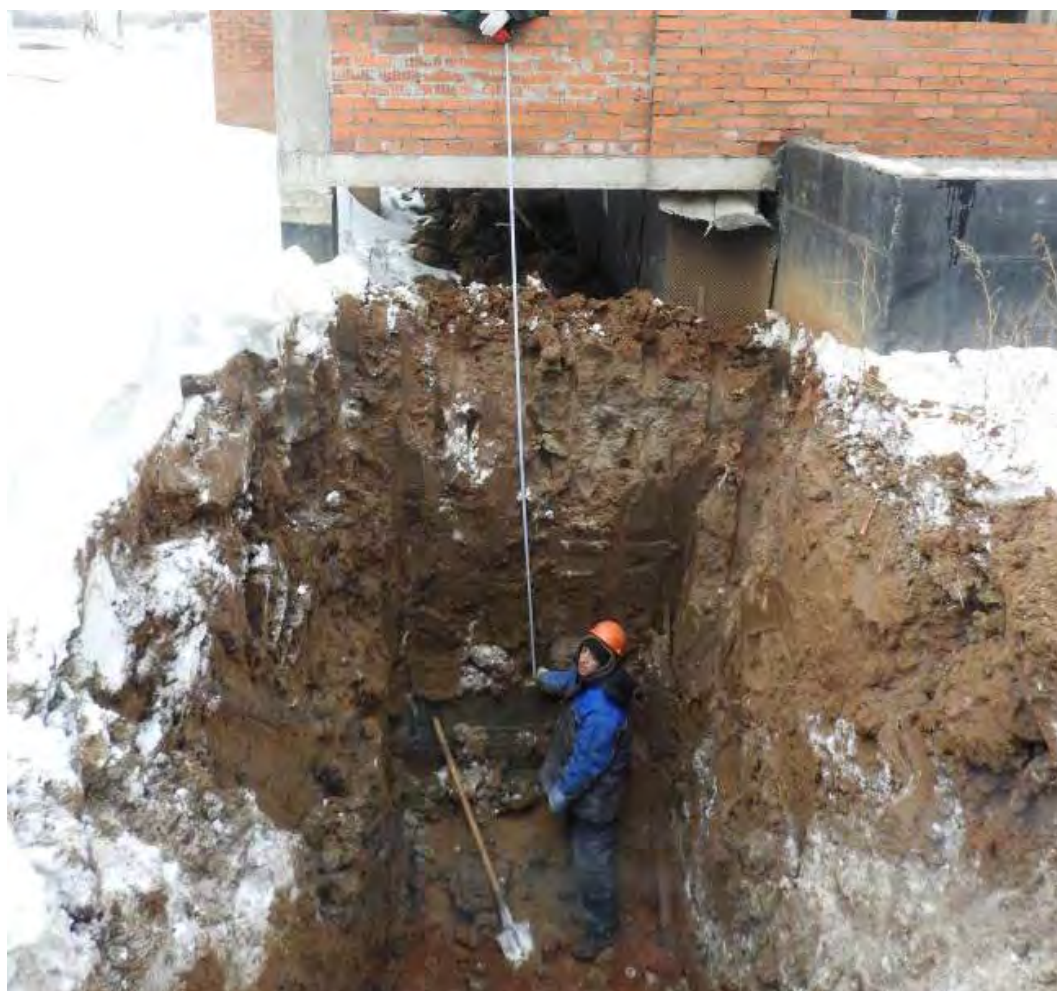
Рис. 3.1.2. Общий вид разработанного шурфа секции 2 между осями 7-9 по оси Ш
