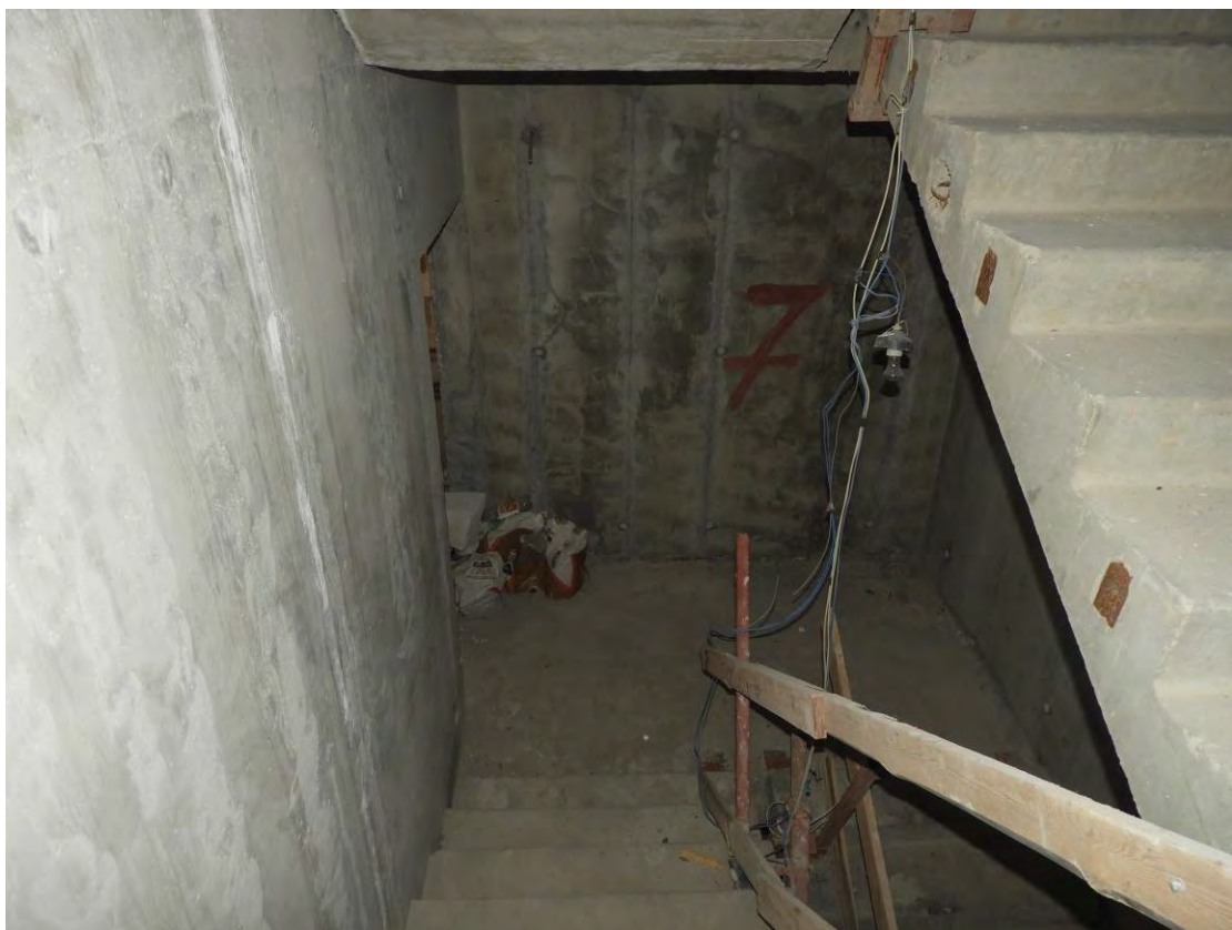
Рис. 3.5.1. Общий вид лестницы 6-ой секции в осях «Л-Р/31-32»
