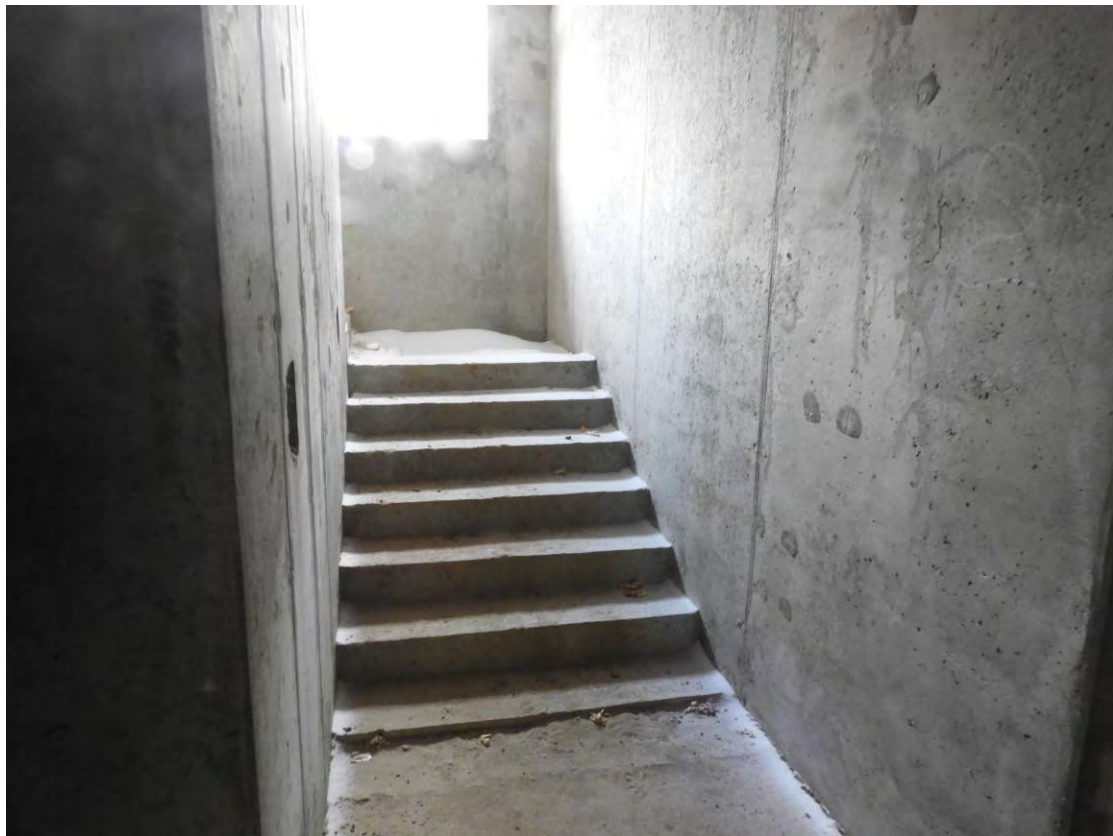
Рис. 3.5.1. Общий вид лестницы 2-ой секции в осях «Ш-Ю/8-10»
