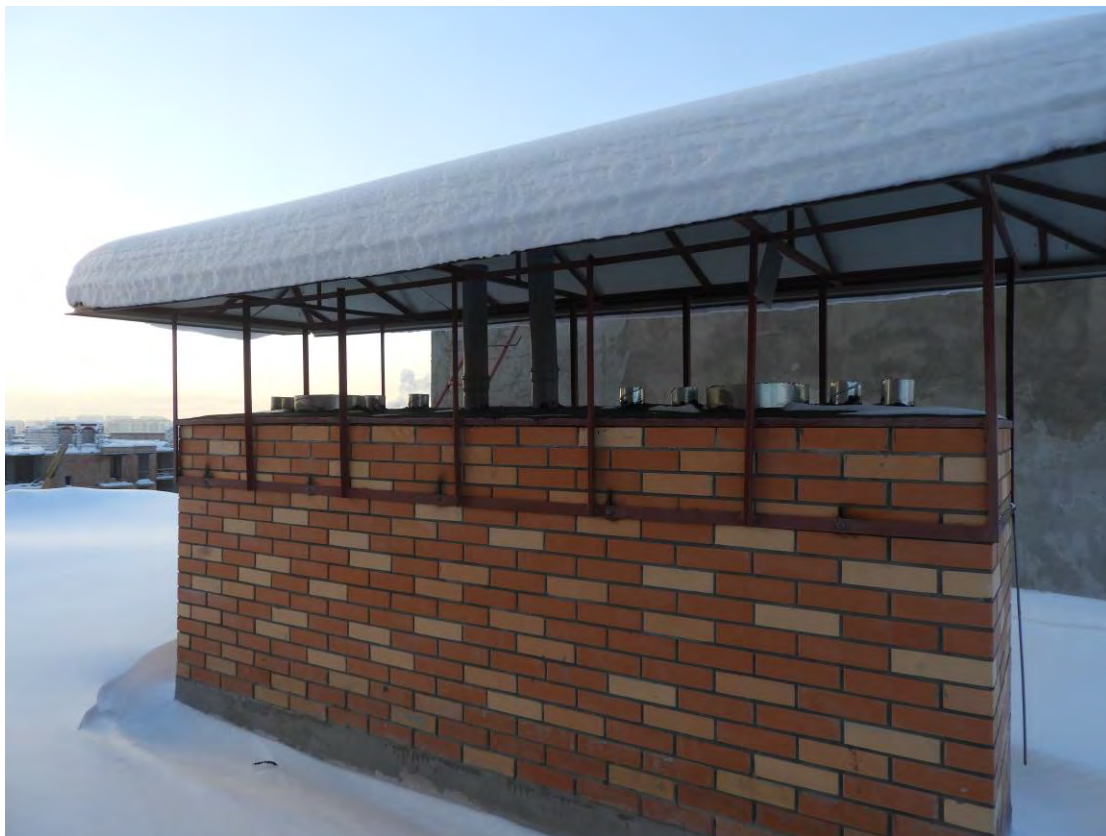
Рис. 3.7.3.5. Общий вид вытяжной шахты установленной на кровле здания
