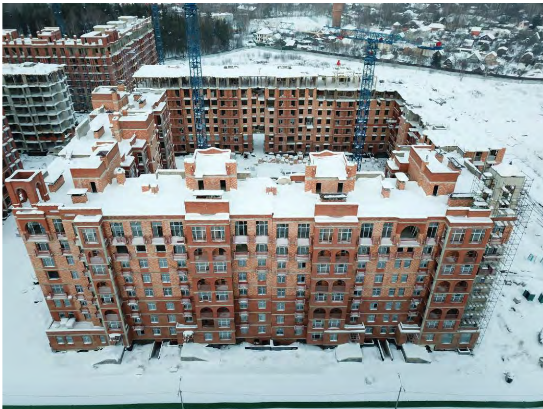
Рис. 1.2. Фасад жилого дома №5 корпус 1 в осях А/1-37
