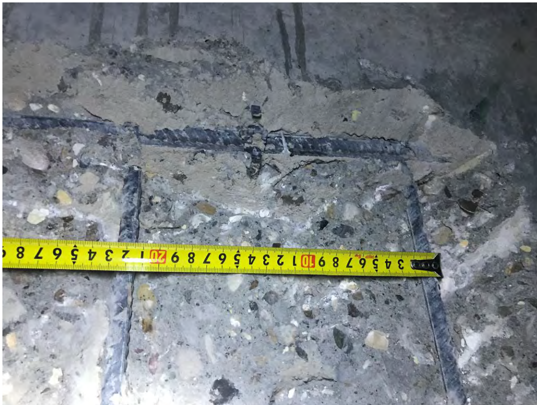
Рис. 3.2.5. Замер шага вертикальных строжней арматуры в монолитной стене лифтовой шахты 2-го этажа секции 1
