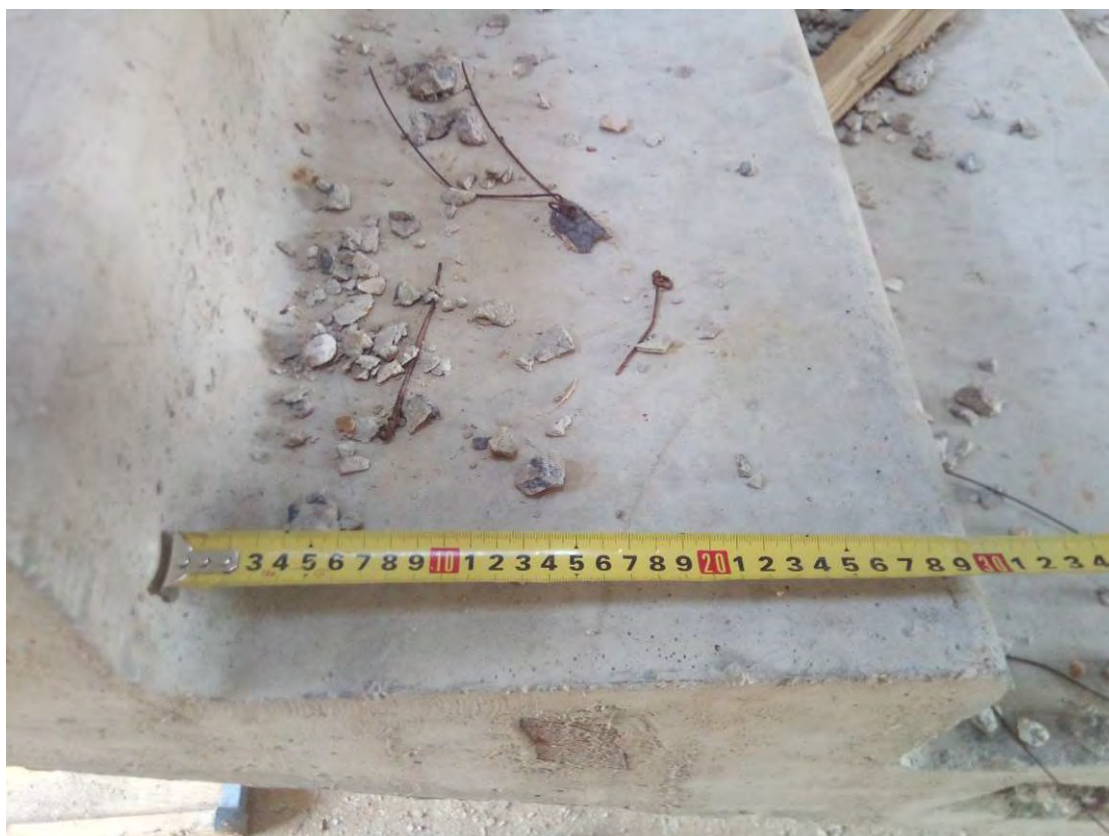
Рис. 3.5.3. Замер ширины проступи лестницы 6-ой секции в осях «Л-Р/31-32»
