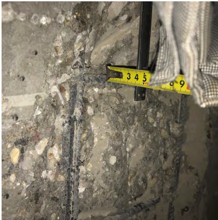
Рис. 3.2.7. Замер толщины защитного слоя бетона в монолитной стене в уровне подвала
