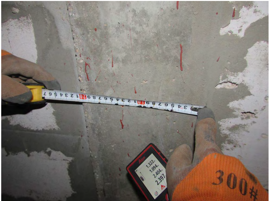
Рис. 2.3. Уточнение толщины внутренних монолитных стен
