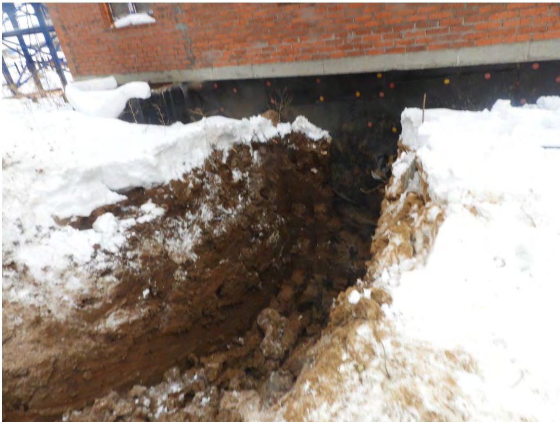
Рис. 3.1.1. Общий вид разработанного шурфа секции 3 между осями 5-6 по оси В,
