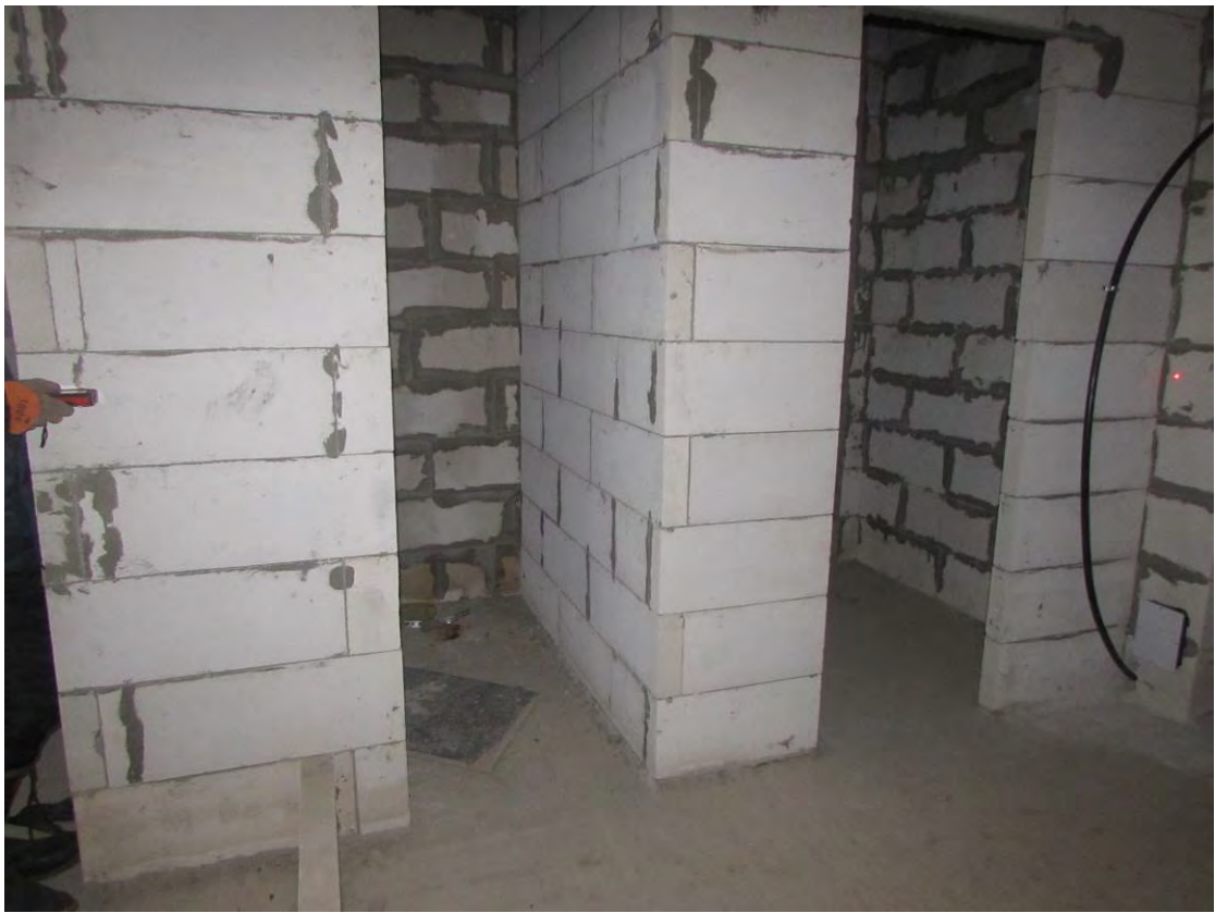
Рис. 3.5.3. Общий вид внутренних смонтированных перегородок
