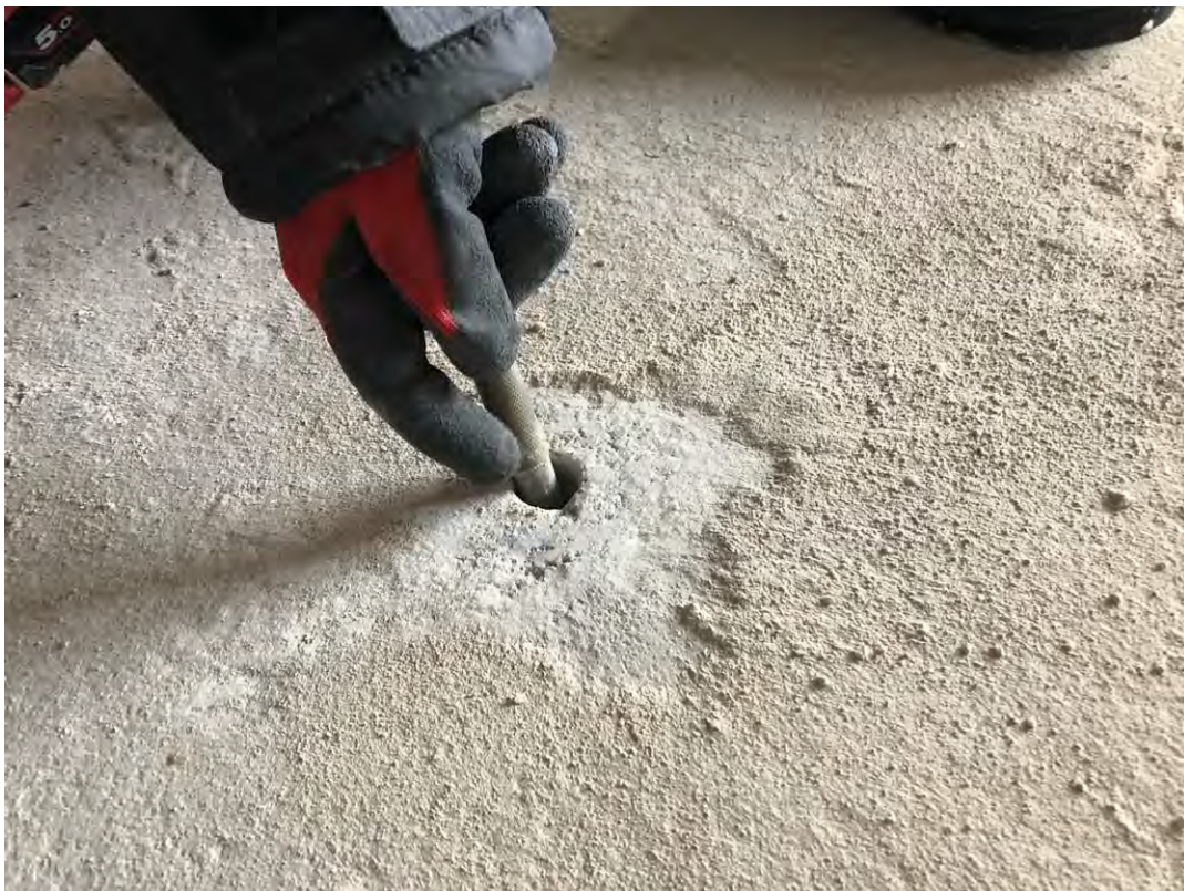
Рис. 4.2.3. Зачистка стенок шпура
