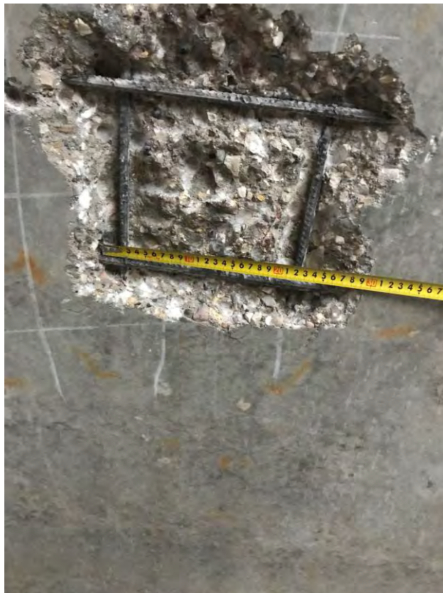
Рис. 3.3.3. Общий вид участка вскрытия плиты перекрытия подвала (зона нижнего армирования)
