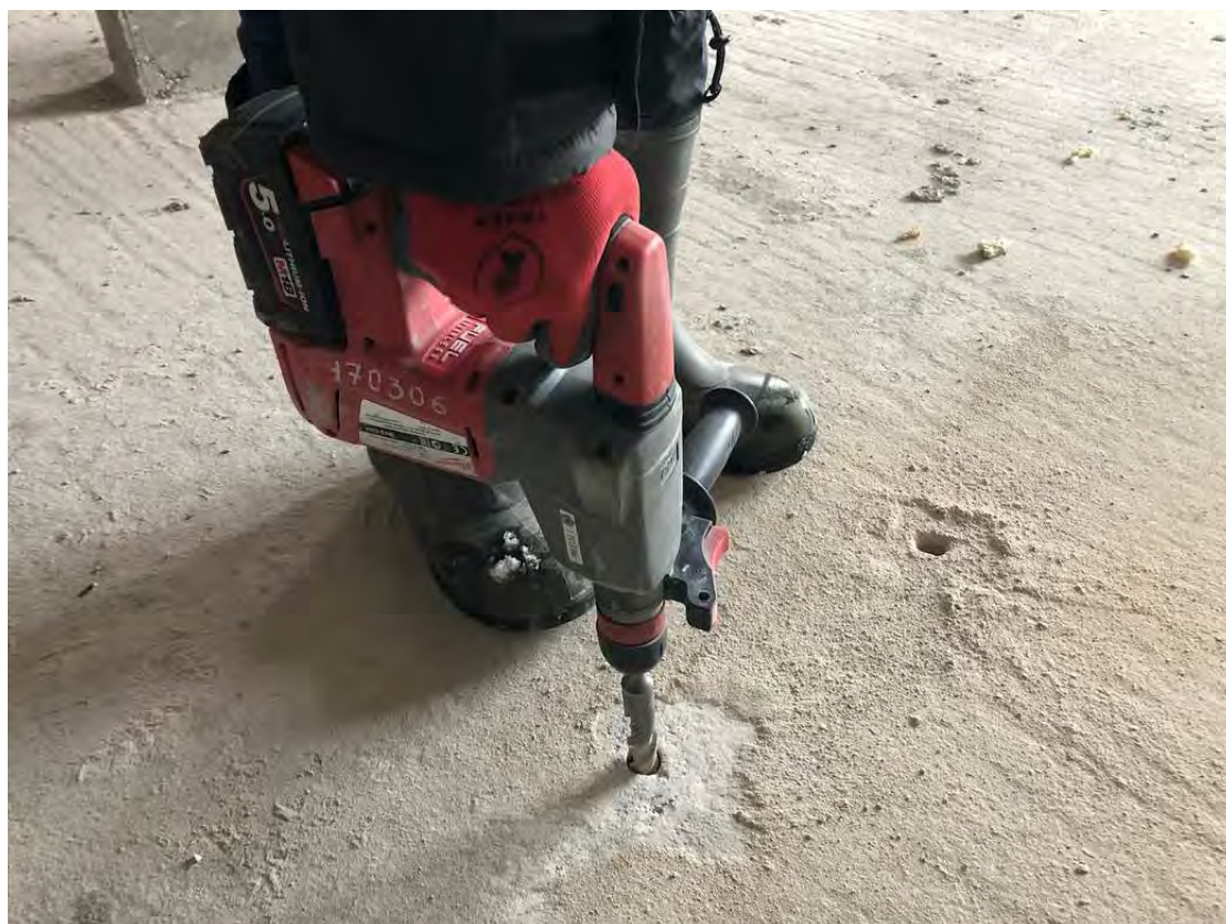
Рис. 4.2.1. Засверливание шпура
