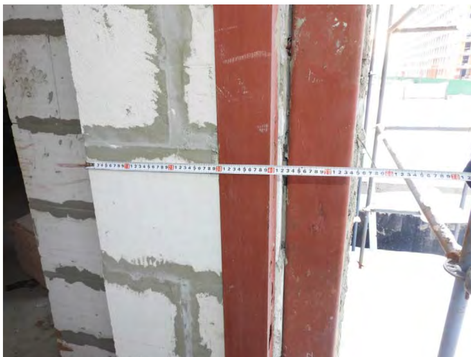
Рис. 3.5.2. Замер толщины наружной стены жилого дома (тип 1)
