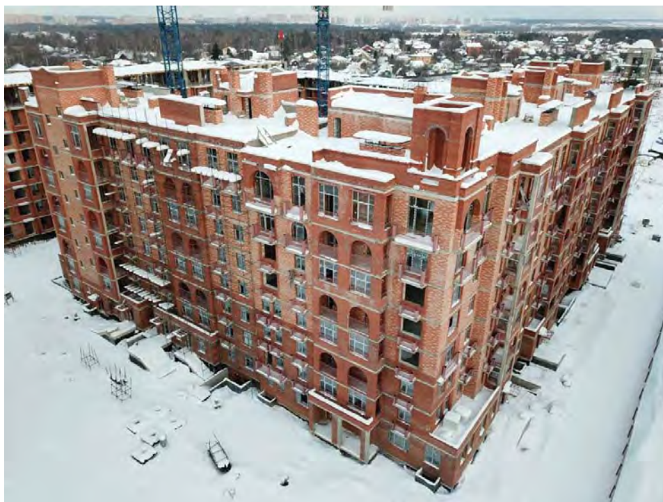
Рис. 3.5.1. Общий вид ограждающих конструкций наружных стен жилого дома
