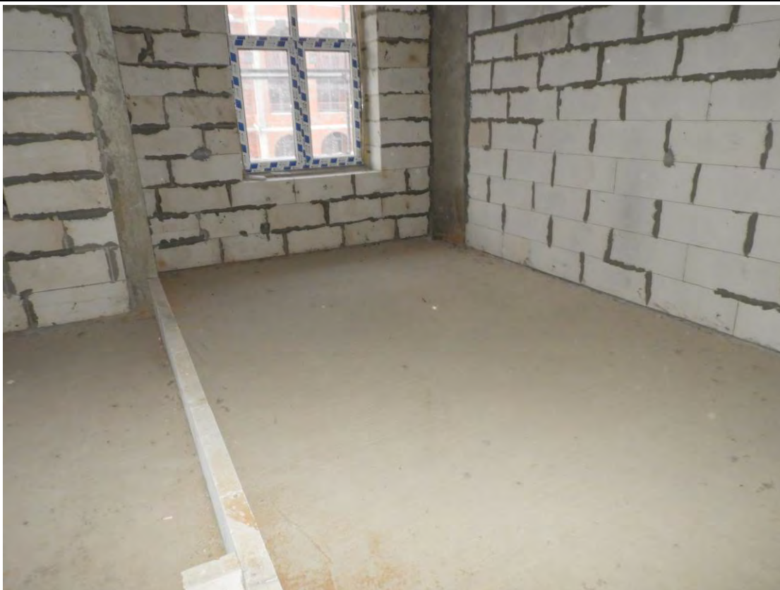
Рис. 3.3.1. Общий вид монолитной ж.б. плиты перекрытия 5-го этажа секция 3
