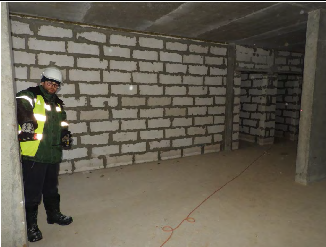
Рис. 3.2.3. Замер шага монолитных пилонов 1-го этажа
