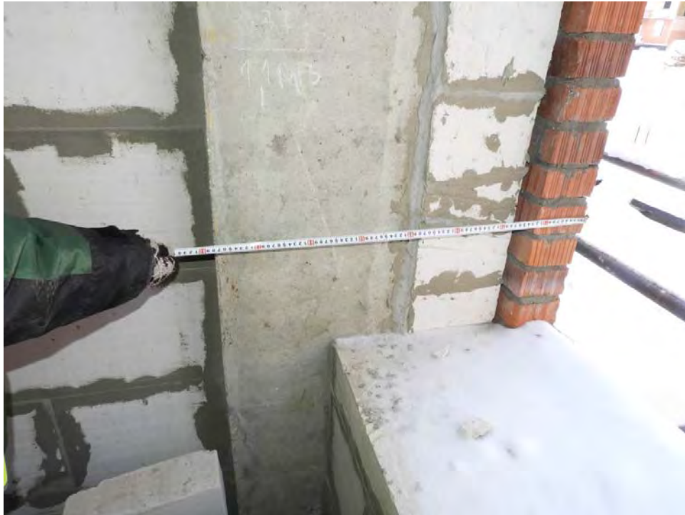
Рис. 2.1. Уточнение толщины наружных стен I-го типа
