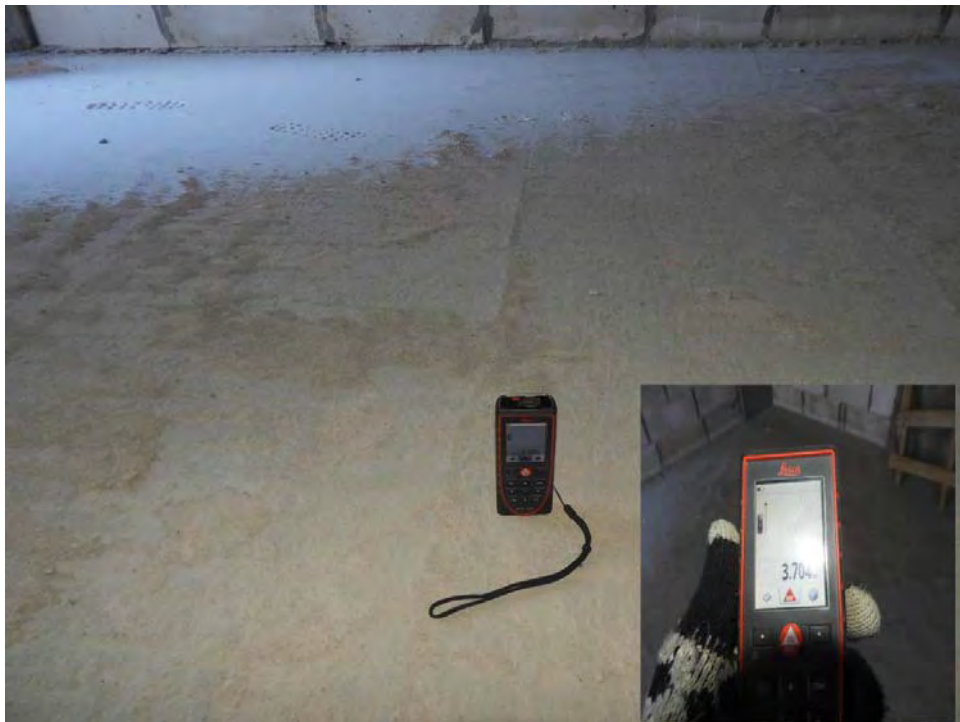
Рис. 2.2. Замер высоты помещений 8-го этажа при помощи лазерного дальномера
