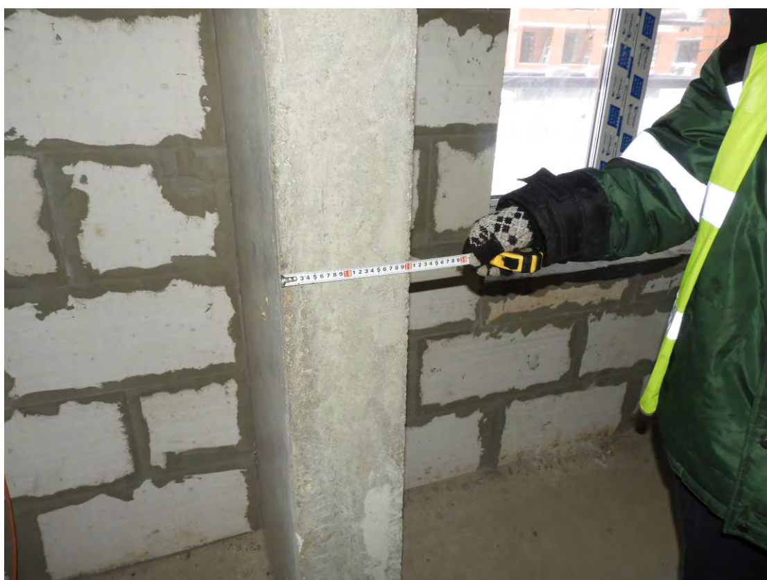
Рис. 3.2.2. Замер сечения монолитного ж.б пилона 1-го этажа
