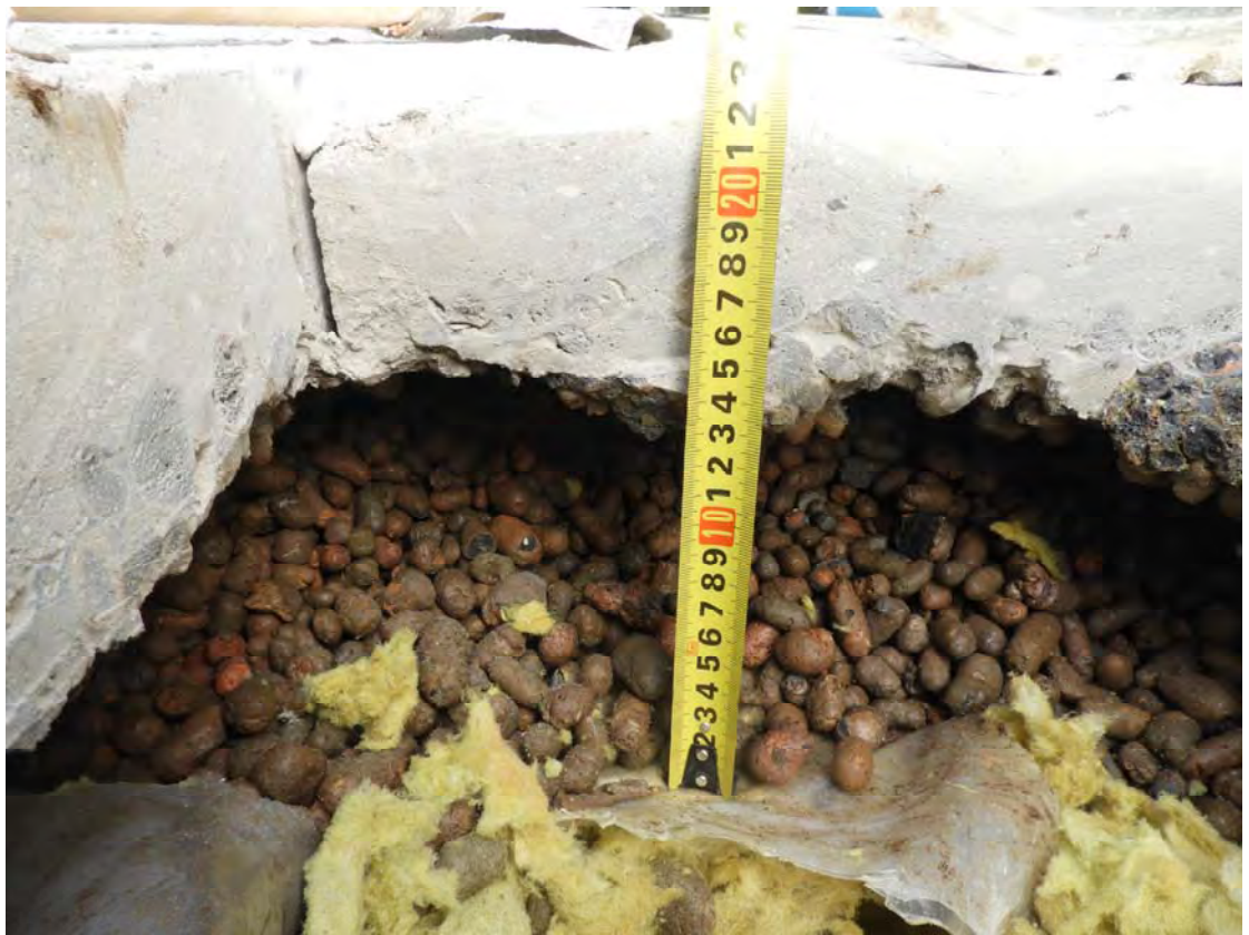
Рис. 3.6.4. Замер толщины разуклонки из керамзитового гравия
