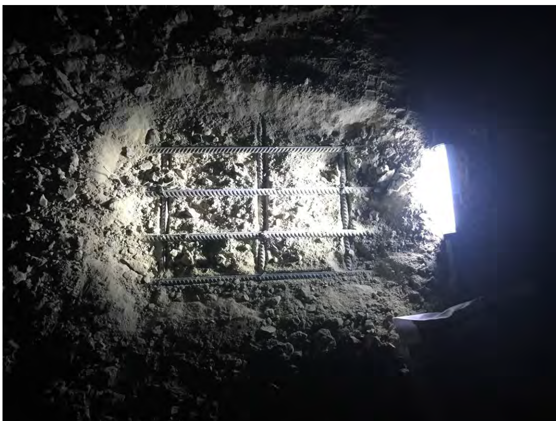
Рис. 3.1.6. Общий вид вскрытия фундаментной плиты в верхней зоне на пересечении осей РР и ТТ и между осями 11-14
