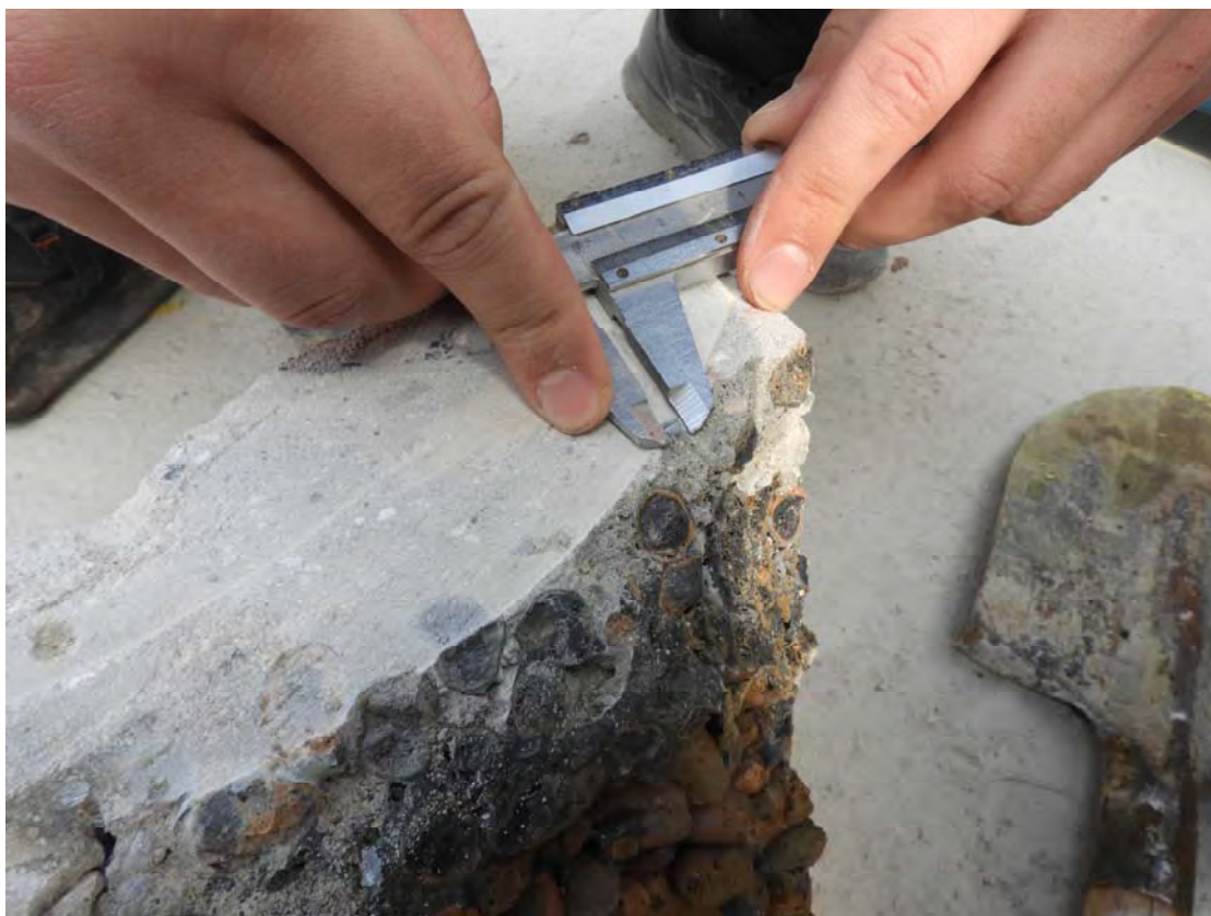
Рис. 3.6.6. Замер диаметра арматурной проволоки (d=5 мм)
