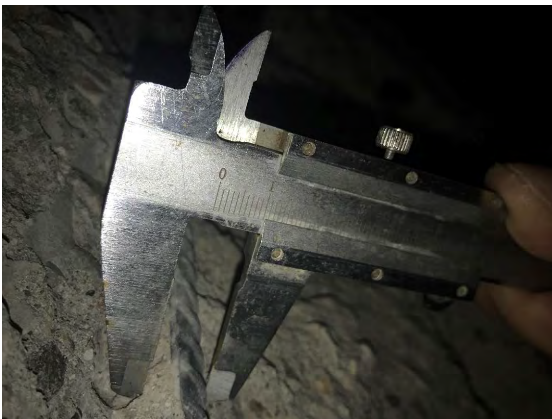
Рис. 3.2.6. Замер диаметра вертикального армирования в монолитной стене в уровне подвала
