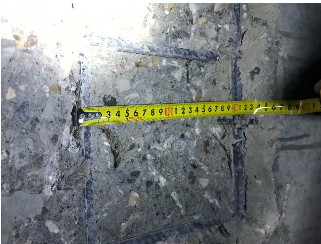
Рис. 3.2.4. Замер шага вертикальных стрежней арматуры в монолитной стене подвала
