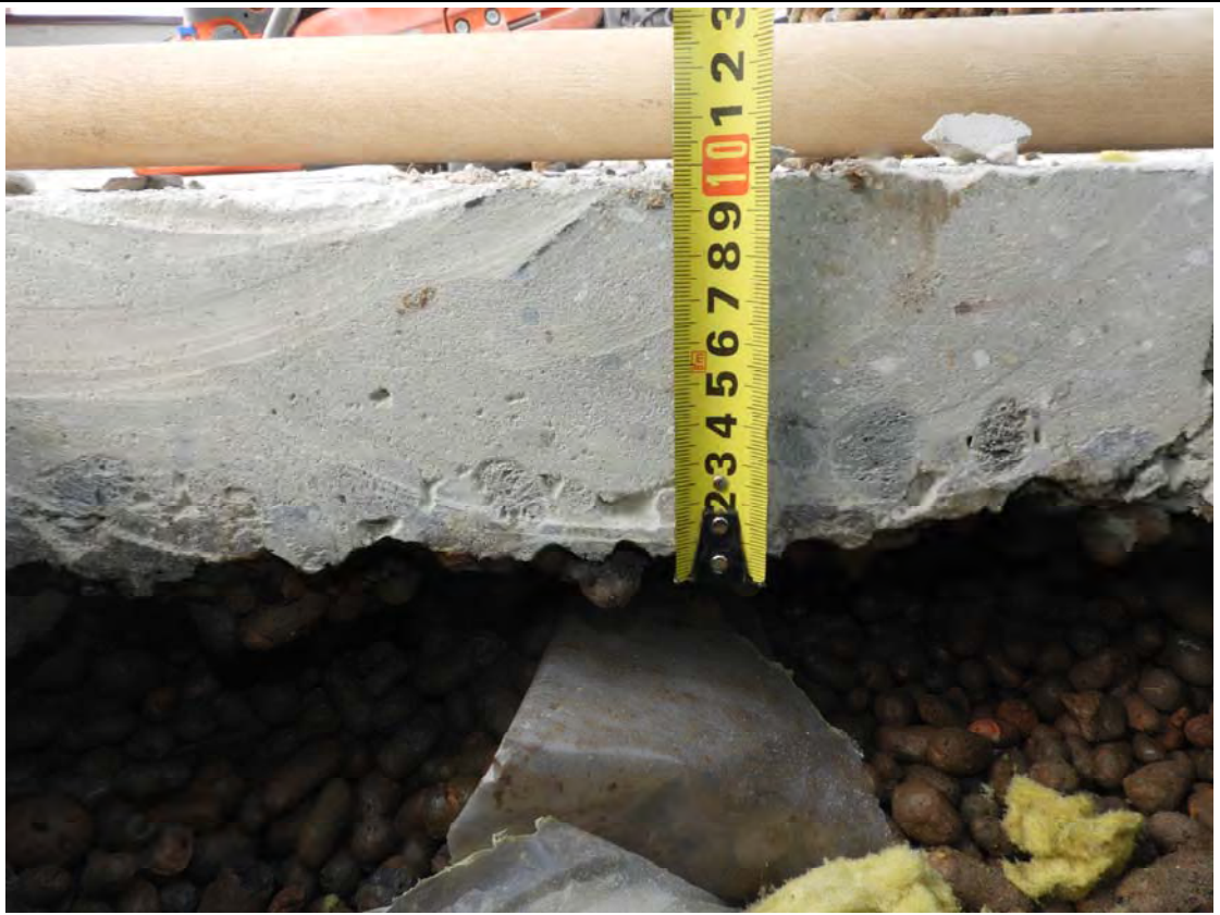
Рис. 3.6.3. Замер толщины стяжки из цементно-песчаного раствора
