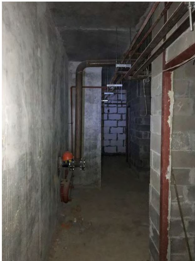
Рис. 3.7.2.3. Общий вид внутреннего водостока в подвальном этаже
