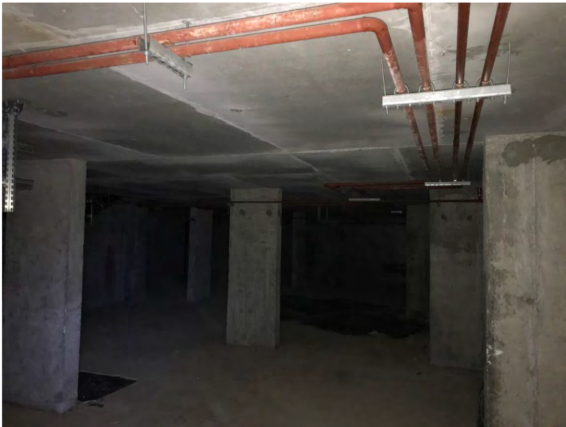
Рис. 3.1.3. Общий вид пространства подвальных помещений жилого дома
