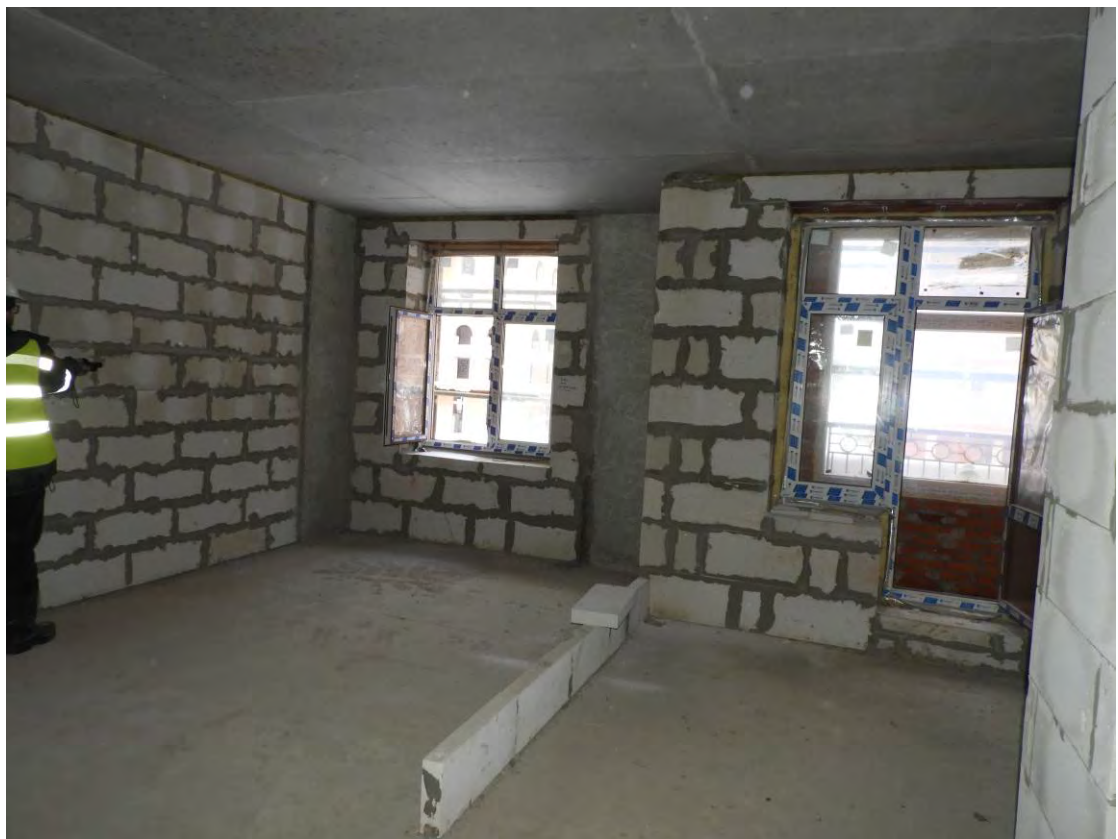
Рис. 1.4. Общий вид внутреннего пространства типового этажа секции №2 между осями Ю-ББ/8-12
